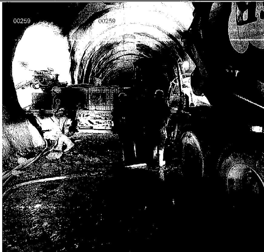
Sopra, i lavori del tunnel di base del Brennero BBT. La fine è prevista per il 2032. A destra, alcuni Tir in sosta all'Autoporto Sadobre a Vipiteno. Sotto, René Zumtobel, assessore all'Ambiente e alla Mobilità del Tirolo
